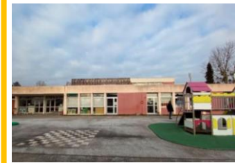
Réhabilitation de l'école des Sables à Villennes S/ Seine
